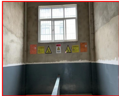
5#厂房内危险废物暂存间（内部）
