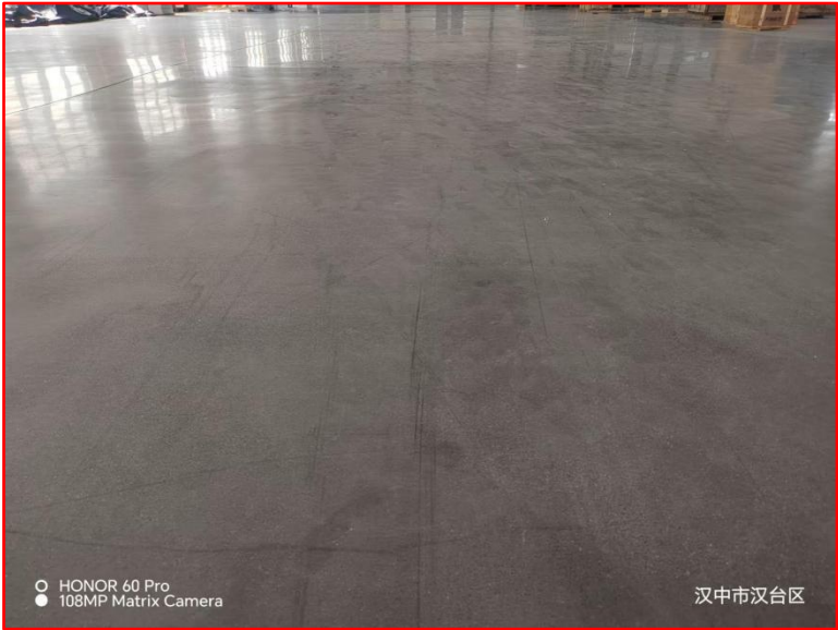
本项目所在车间地面现状图
