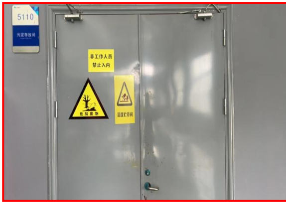
5#厂房危废暂存库
