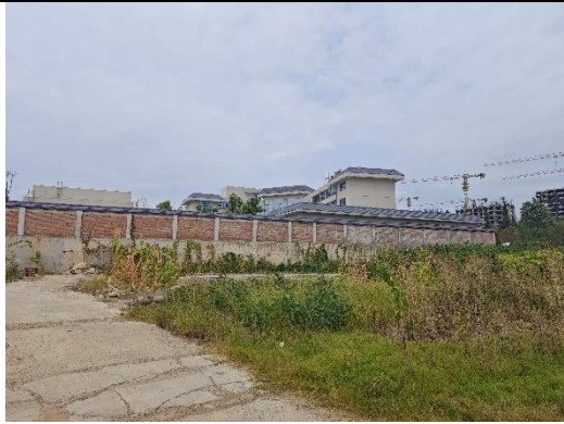
北城区供水加压服务站
