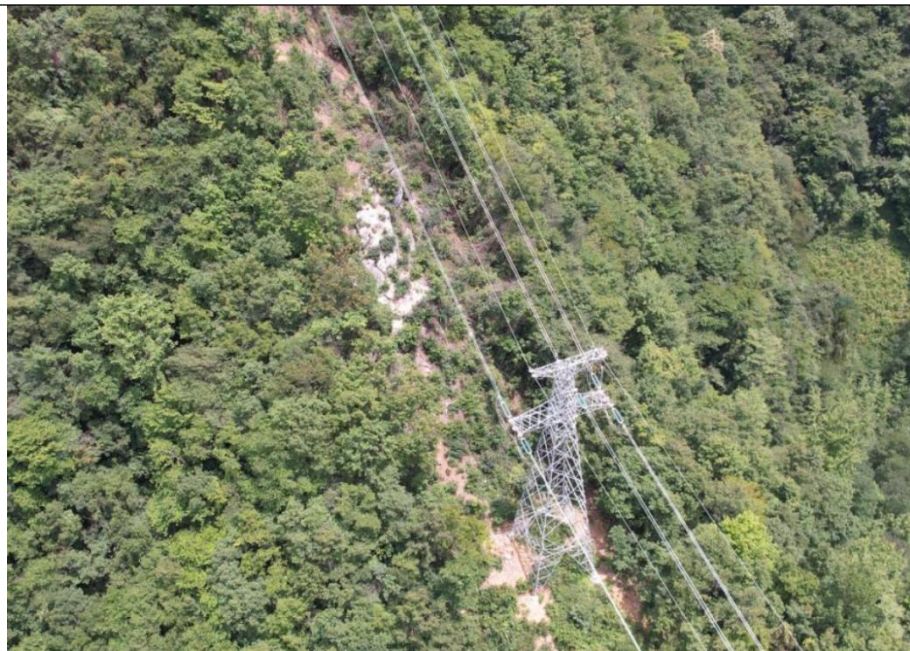
36#塔周边施工便道植被现状
