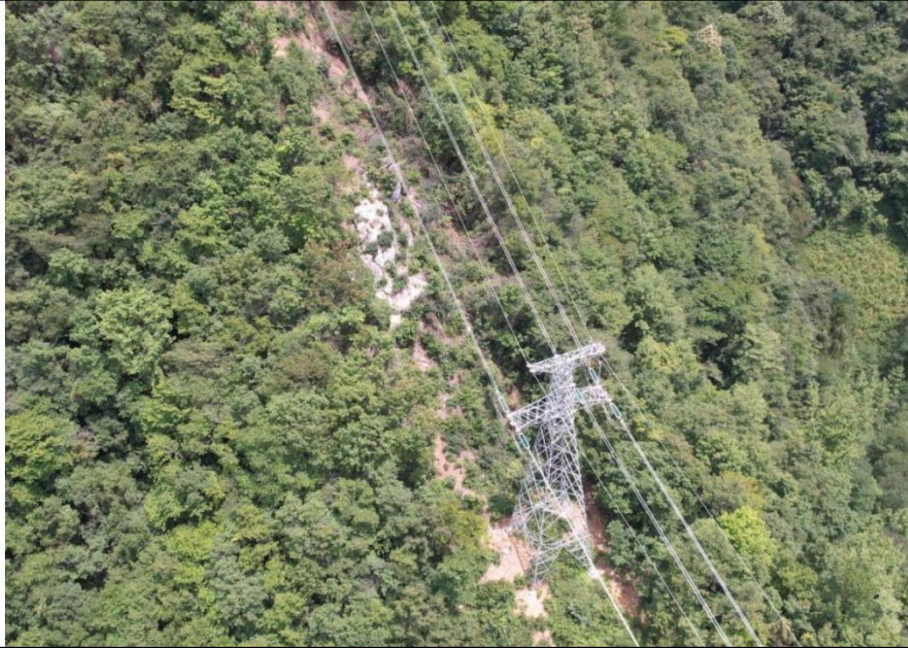
36#塔周边施工便道植被现状
