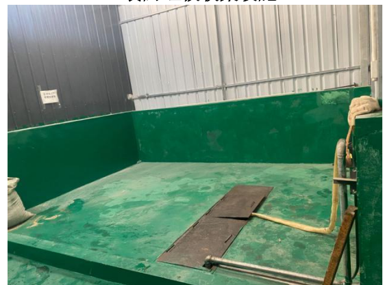
危废暂存设施
