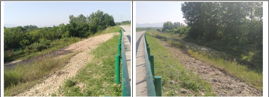
汉江右岸堤顶路外侧裸露边坡
