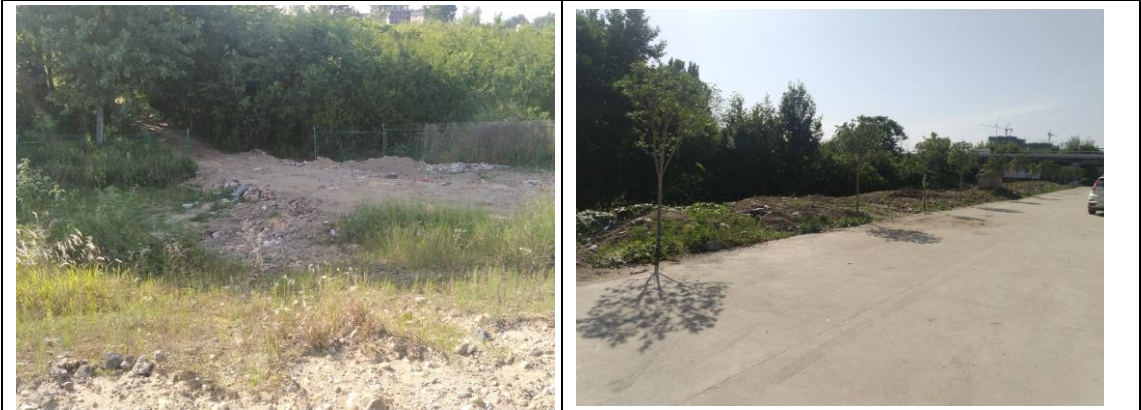
汉江右岸大堤外侧堆放渣土
